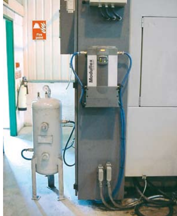
Sistema de Aire Seco Moduflex instalado para suministrar aire de control para un centro de máquinas CNC
